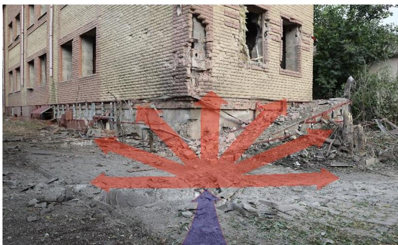
*Рис. 12 – Направление разлёта основного потока осколков в случае попадания №2.*
