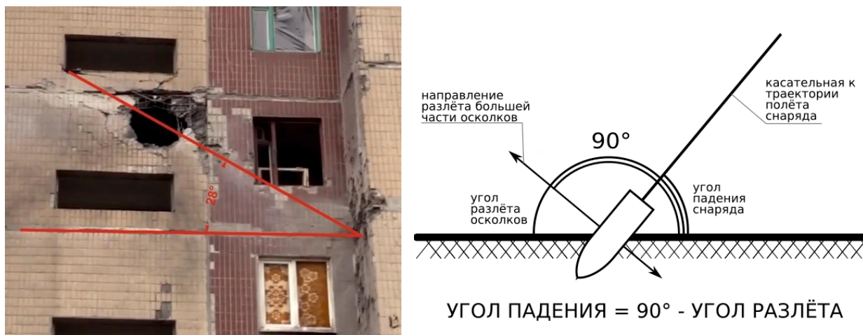
Рис. 13 – Определение угла разлёта осколков по следам попадания 2 20 .
