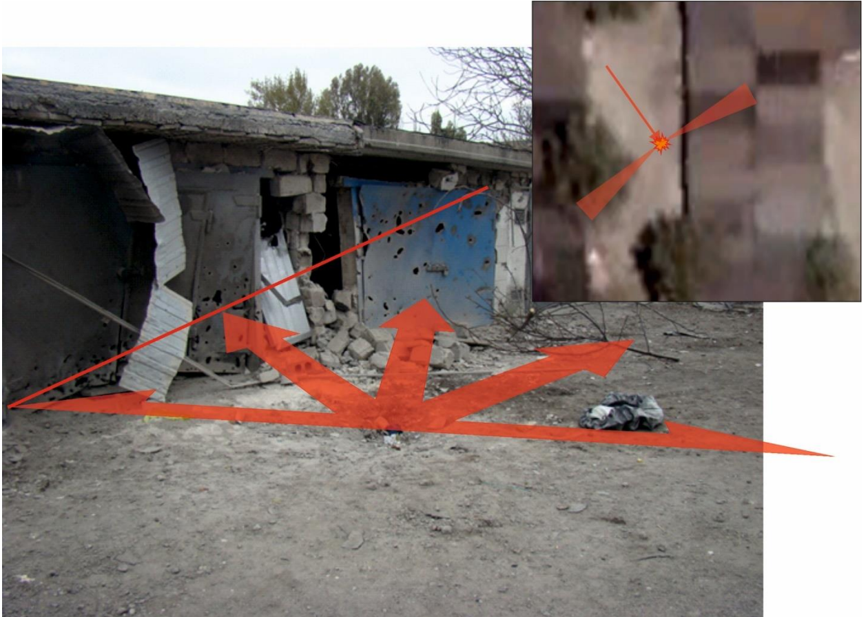
Рис. 15 – схема взрыва снаряд в случае попадания 1.
