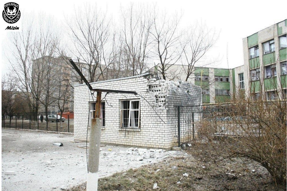
Рис. 2 – Разрушенный восточный угол крыши котельной в результате попадания №1 24 .
