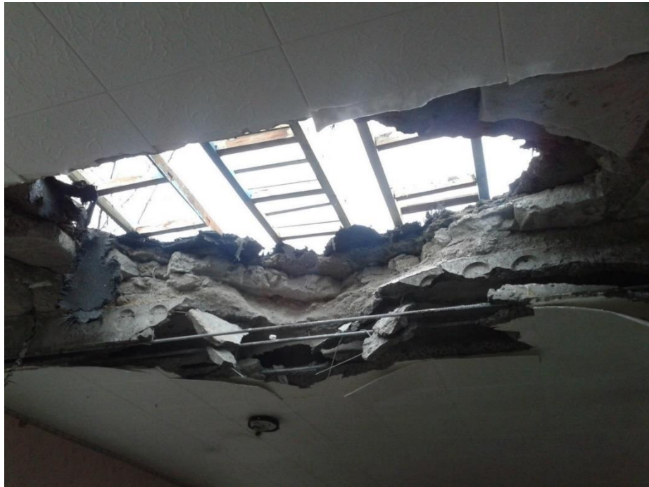
Рис. 3 – Сквозное отверстие в крыше детского сада в результате попадания №2 25 .
