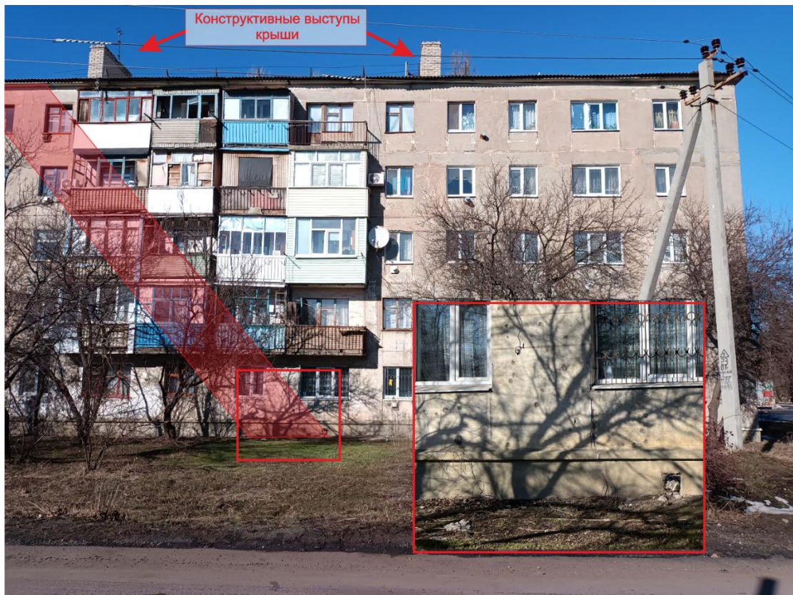
Рис. 37 - Линия основного потока разлета осколков на жилом доме в результате попадания №8.
