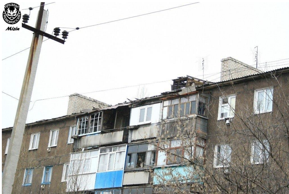
Рис. 11 – Вид на разрушенную крышу в результате попадания №6 30 .
