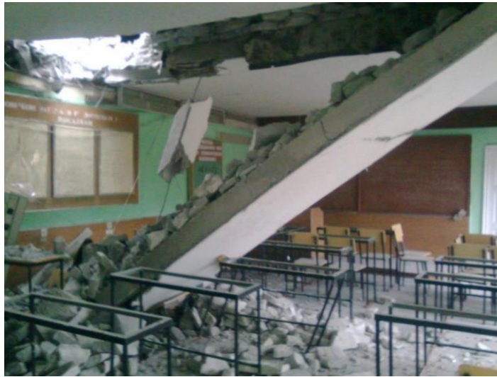
Рис. 17 – Перекрытия учебного класса техникума, обрушившиеся в результате попадания №7 36 .
