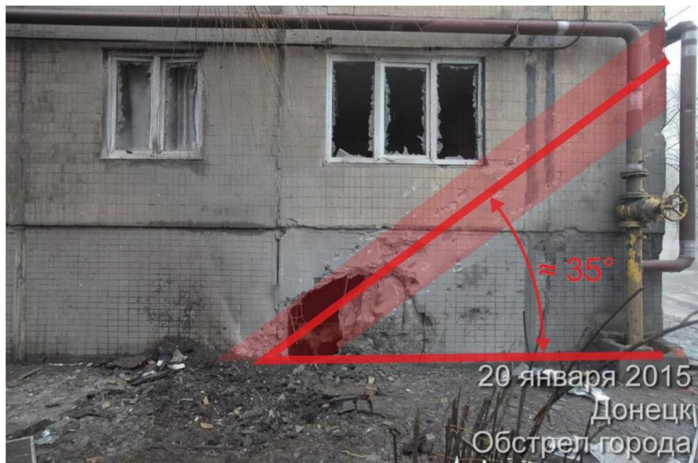
Рис. 31 – Угол разлёта осколков (попадание №3)<sup>57</sup>.
