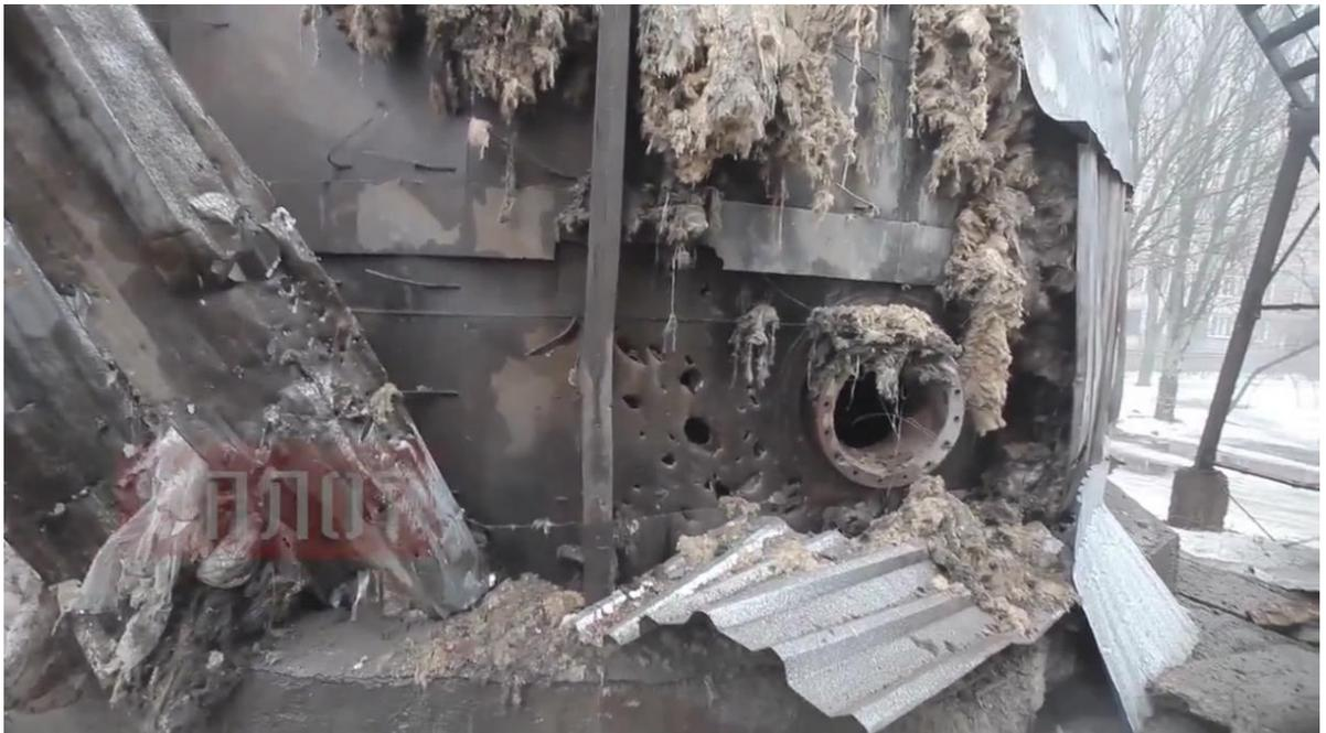
*Рис. 5 – Техническая ёмкость котельной, повреждённая взрывом<sup>40</sup>.*
