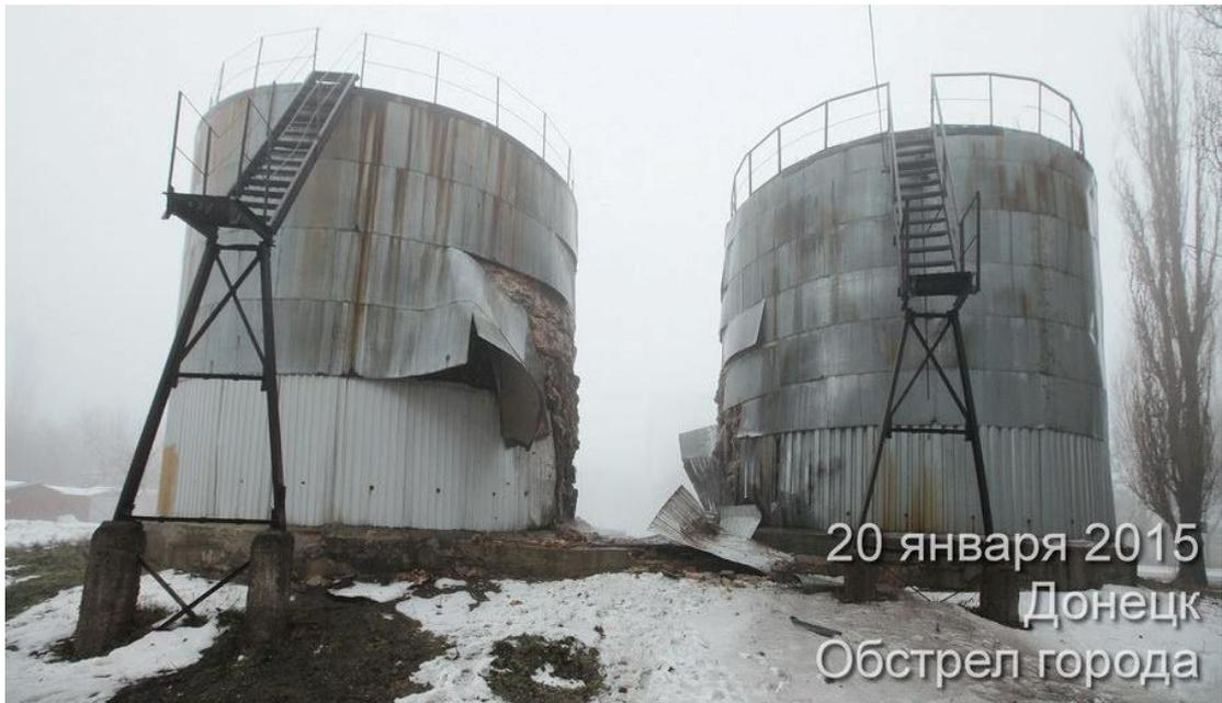
*Рис. 6 – Технические ёмкости котельной, расположенной возле дома №10 по ул. Политбойцов, г. Донецк. Детонация снаряда произошла между ёмкостями<sup>41</sup>.*
