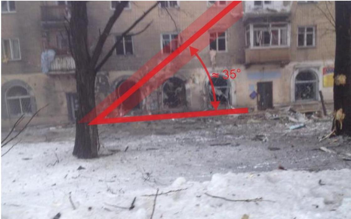
Рис. 32 - Угол разлёта осколков (попадание №7)<sup>58</sup>.
