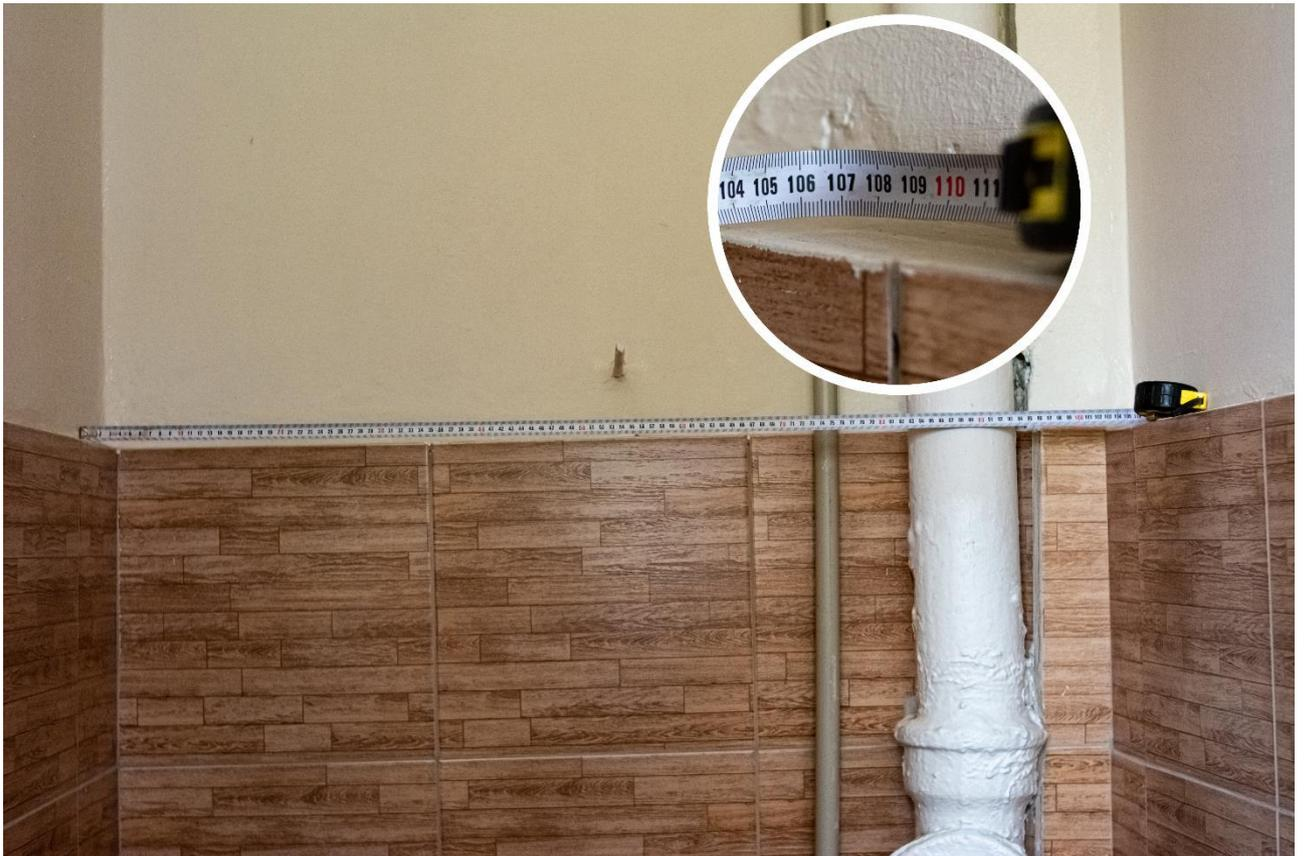
Рис. 17 – Измерение ширины технической ниши в детском саду № 204.
