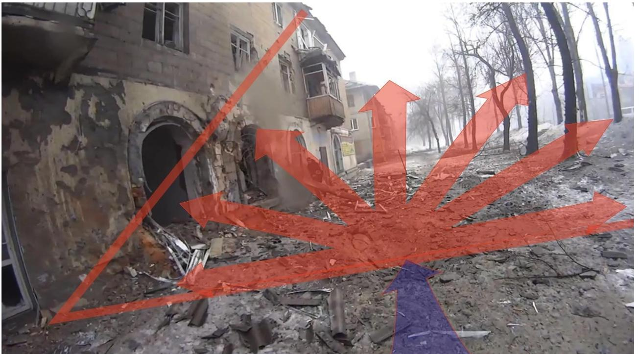
Рис. 27 - Схема разлёта осколков на месте попадания № 7.
