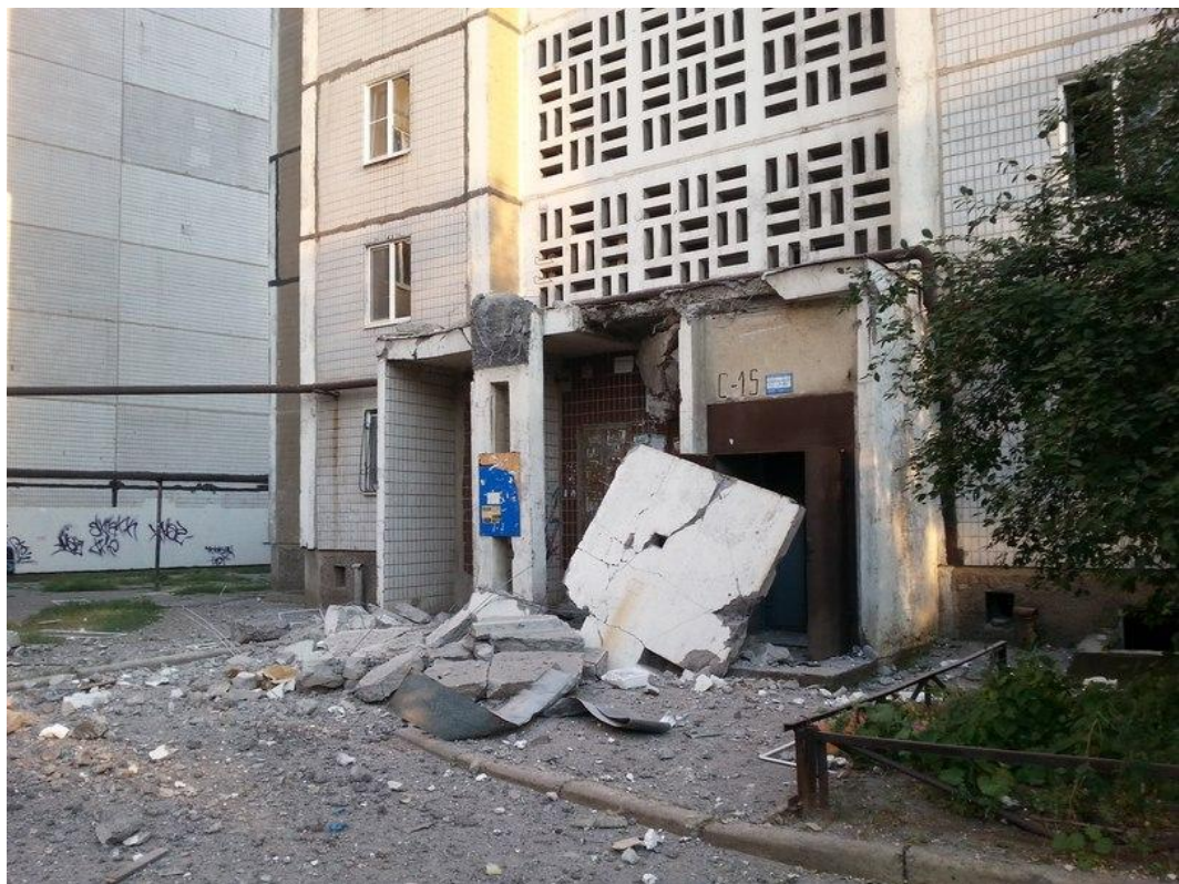
Рис. 13 – Кусок бетонной плиты, упавший на подъезд на месте попадания № 13 31 .
