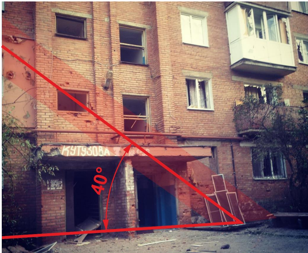
Рис. 31 – Определение угла разлёта осколков (попадание № 14) 45 .
