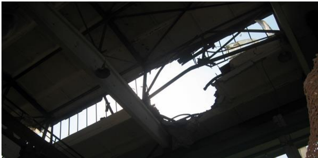
Рис. 15 – Отверстие в крыше здания лаборатории ЭШП ДонНТУ, образовавшееся в результате попадания № 7 44 .
