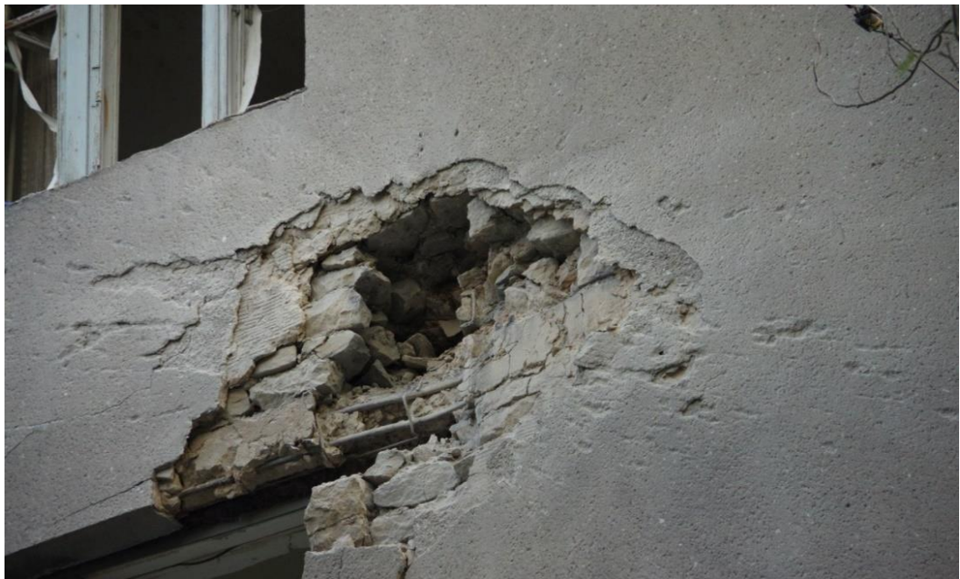
Рис. 3 – Отверстие, образованное на стене дома, в результате попадания № 1 32 .
