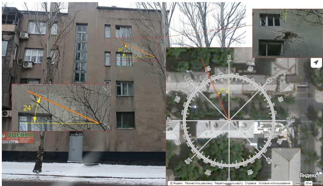
Рис. 26 – Определение угла обстрела по попаданию № 1.
