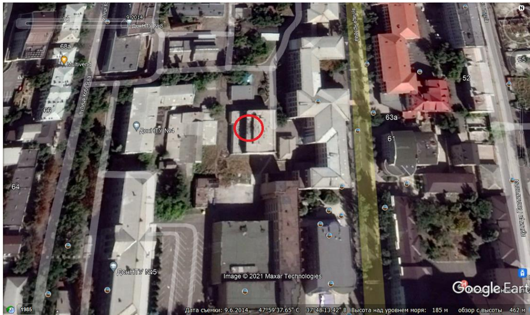
Рис. 16 – След от попадания (№ 7) в крышу здания лаборатории ЭШП на спутниковом снимке от 06.09.2014 г.
