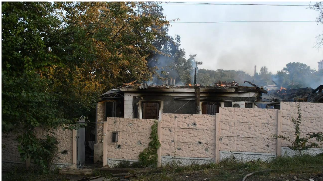
Рис. 9 – Последствие попадания по адресу ул. Ванды Васильевой, д. 17, 27 .
