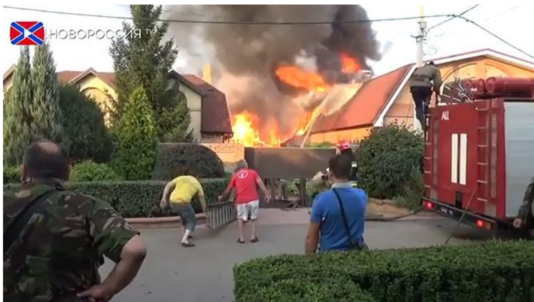
Рис. 3 – Последствие попадания по ул. Коцюбинского, д. 12, где была повреждена кровля и сгорела пристройка 24 .
