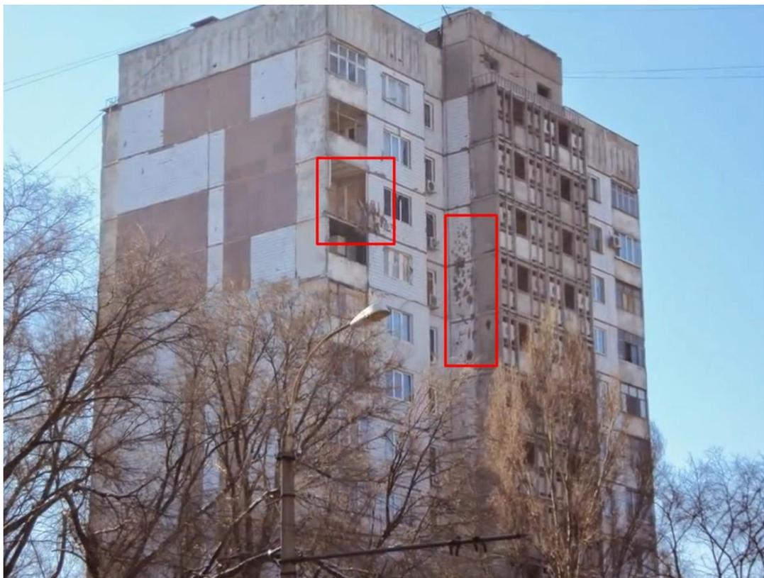
*Рис. 11 – Разрушенный балкон и следы от основного потока разлета осколков на месте попадания №7<sup>40</sup>.*
