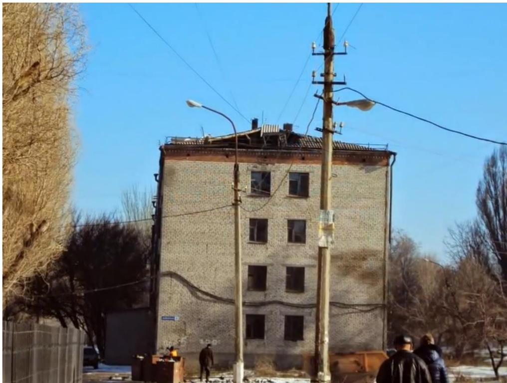
*Рис. 7 – Разрушенная крыша дома в результате попадания №5<sup>36</sup>.*
