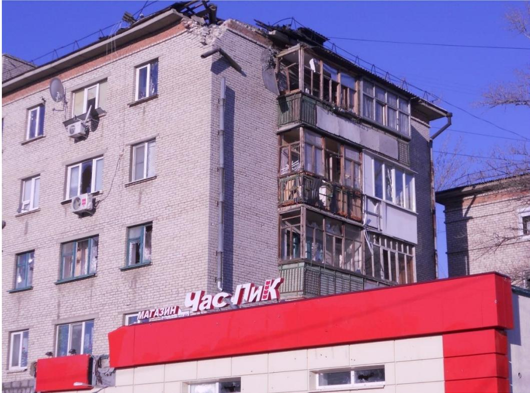
*Рис. 8 – Разрушенный восточный угол дома в результате попадания №5<sup>37</sup>.*
